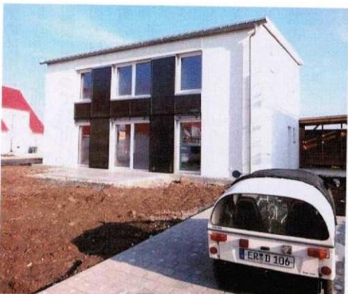
今春に完成したプラスエネルギーハウスのわが家。南面の窓の間には黒い太陽熱パネルを設置。右手前は2人乗りの電気自動車。3m<sup>2</sup>の太陽電池で年間1万km走る。市内移動用。
